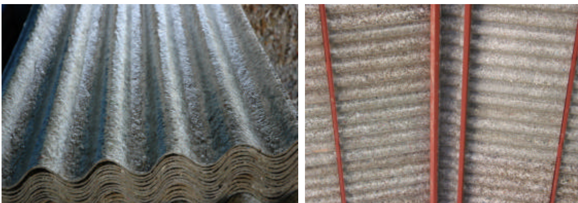
Figura 16 - Telhas produzidas com polietileno & Alumínio e sua utilização em galpão industrial.
